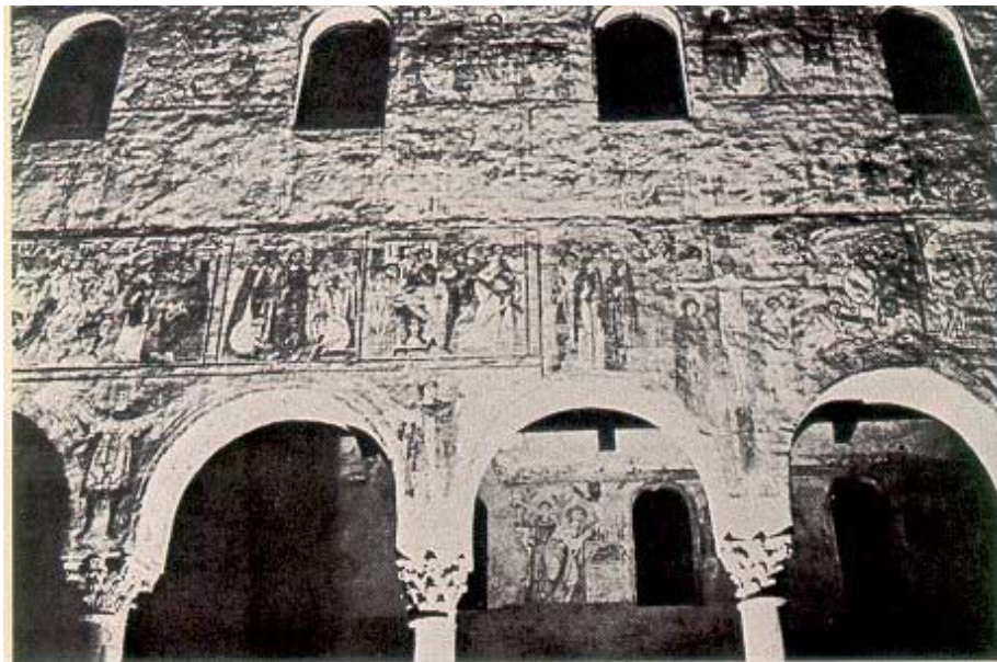
Chiesa di S. Angelo in Formis (1079-1087). La fotografia a luce radente rivela i giunti orizzontali delle pontate sulla parete settentrionale della navata
